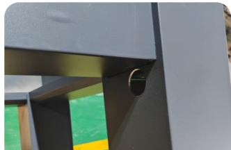
6. 使用直径30以上开孔器开孔，孔开大点方便进线
